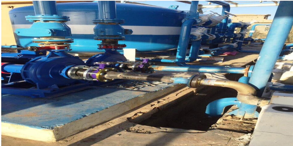
تأهيل محطة ماء الهيتاوين/أبو غريب / حزام بغداد
