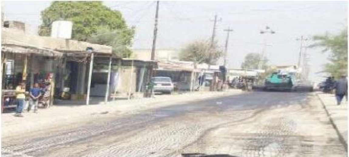
(تأهيل طريق (الحامية - صنيديج) جرف النصر/ شمال بابل)
