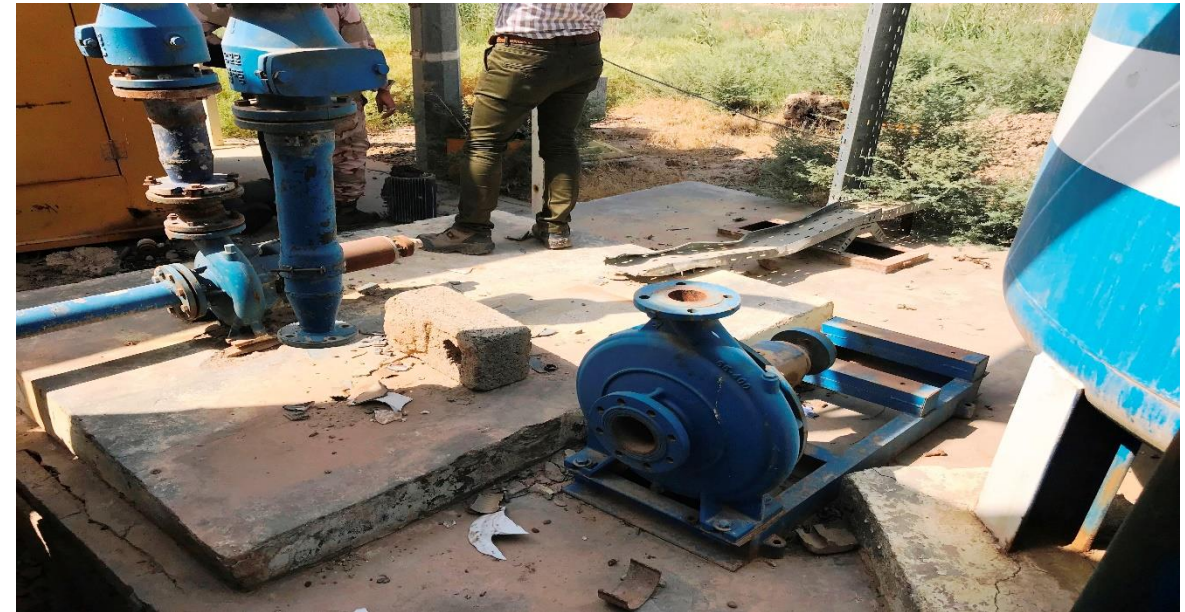
تأهيل محطة ماء الهيتاوين/أبو غريب / حزام بغداد
