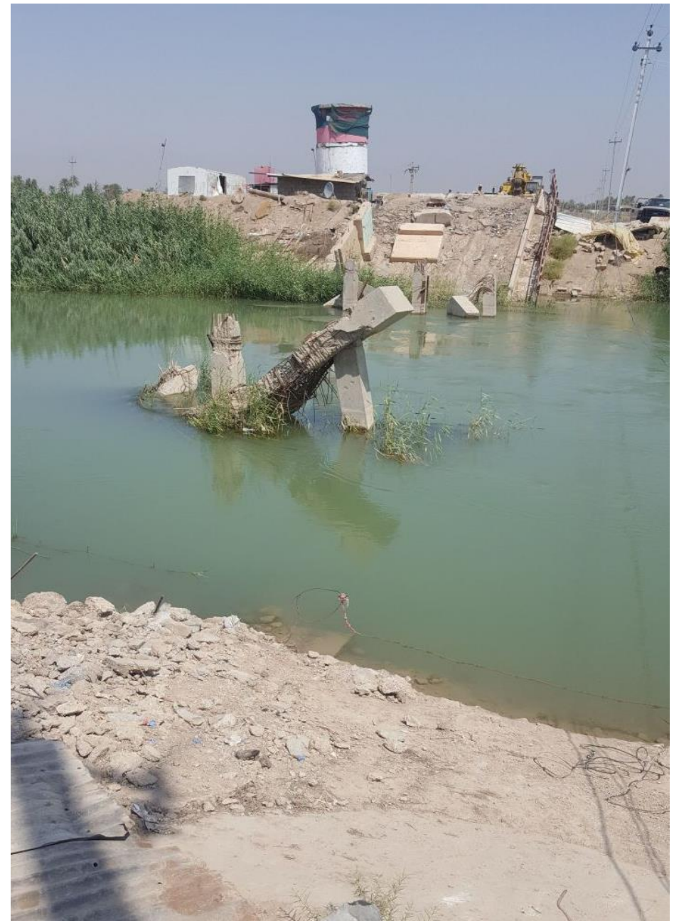
مجسر عودة الشكر / أبو غريب / حزام بغداد
