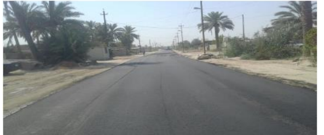
(تأهيل طريق (الحامية - صنيديج) جرف النصر/ شمال بابل)
