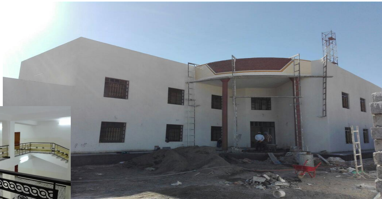
Al Dour police station\ Salah Al Din
