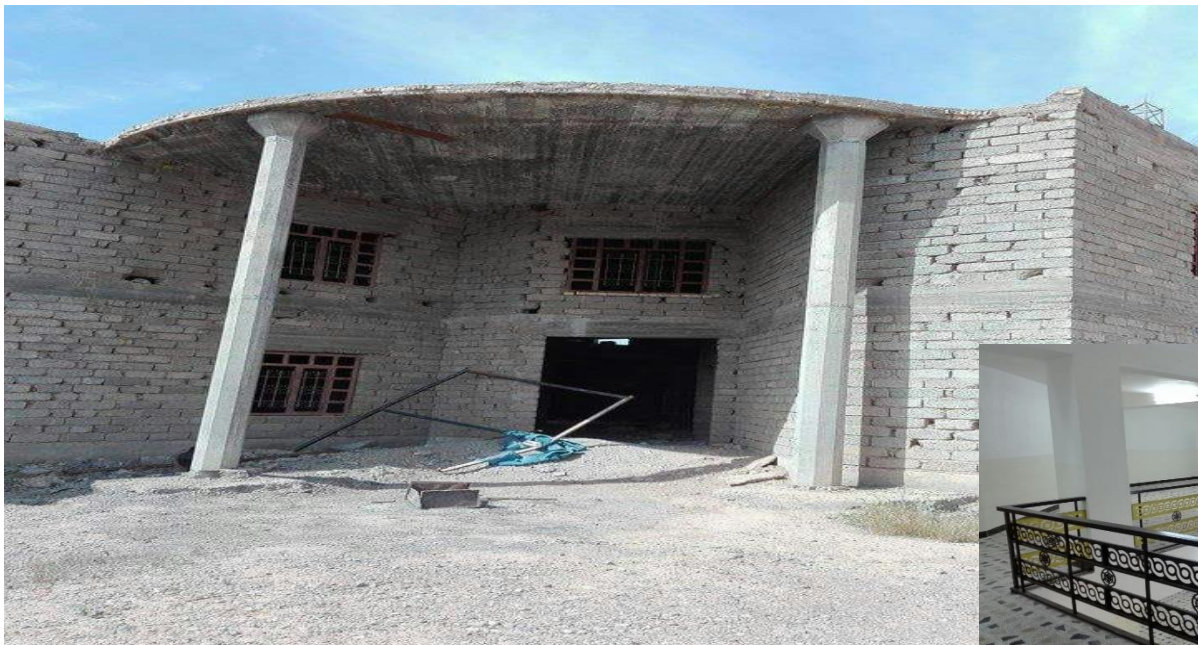
Al Dour police station\Salah Al Din
