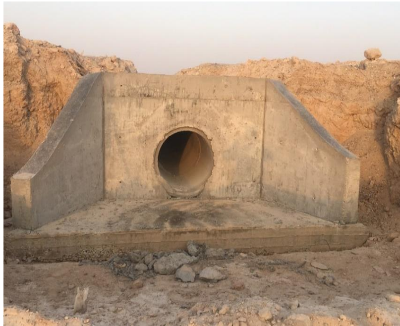
اعمار وإعادة تأهيل طريق الرمادي - هيت 52
