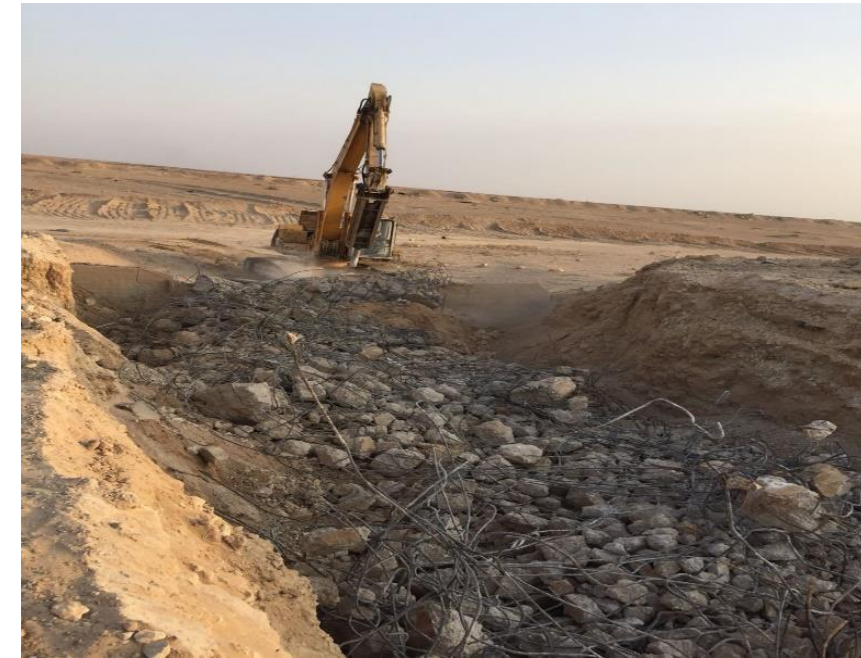
اعمار وإعادة تأهيل طريق الرمادي - هيت
