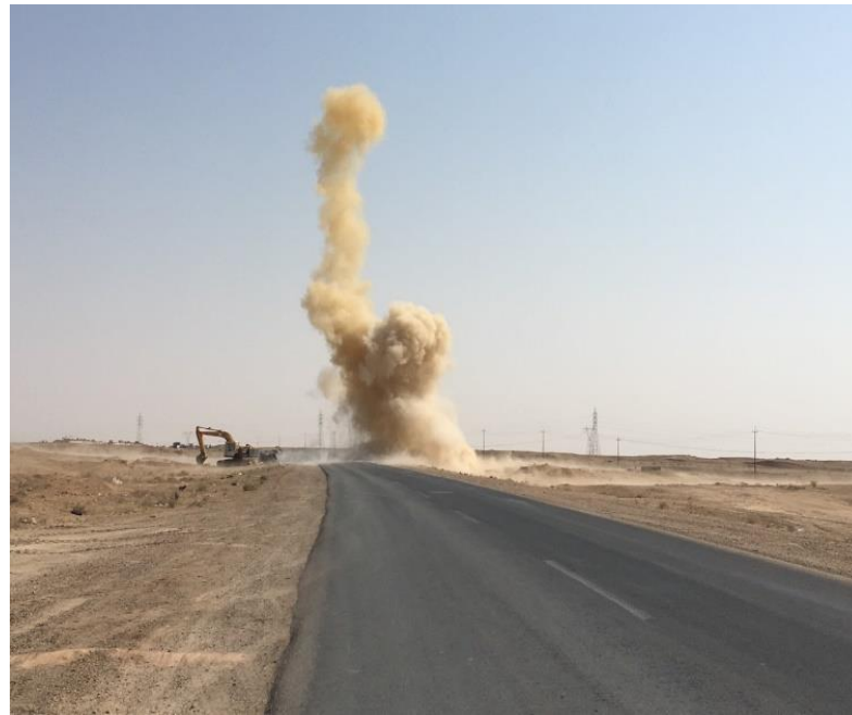
اعمار وإعادة تأهيل طريق الرمادي - هيت (انفجار عبوة اثناء العمل)
