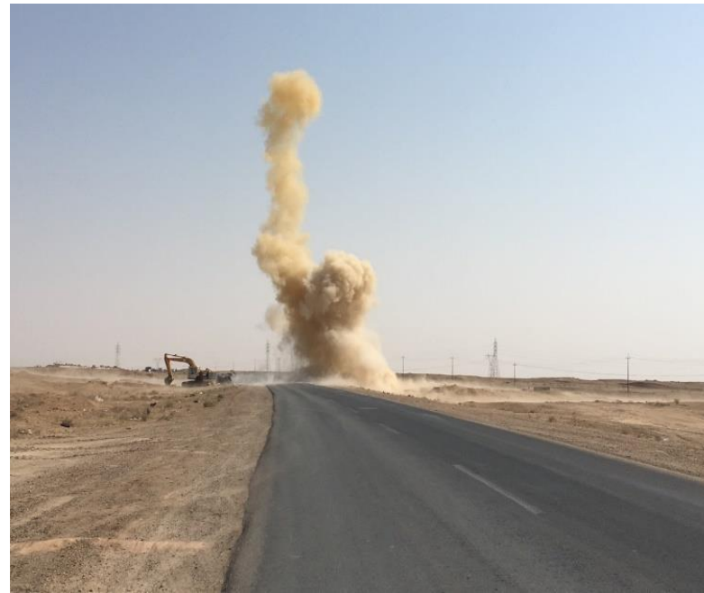
اعمار وإعادة تأهيل طريق الرمادي - هيت (انفجار عبوة اثناء العمل)
